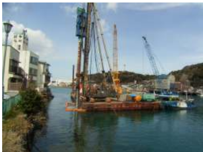
施工状況写真
