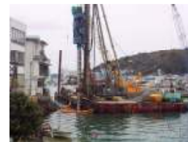
④貫入状況
