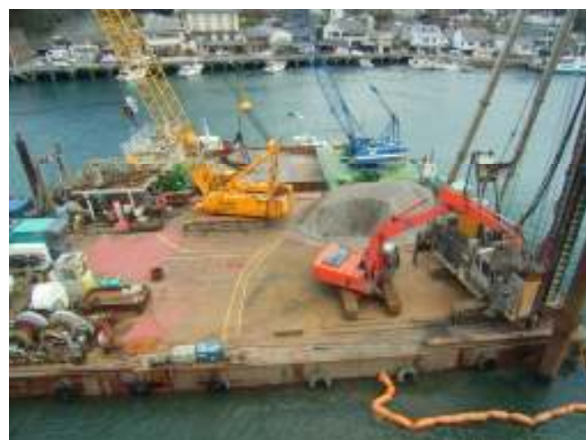
施工重機配置
