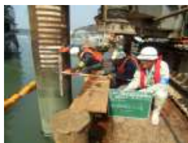
③改良天端高確認
